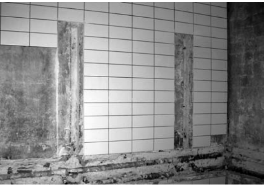
Baustelle in der Gästedusche
